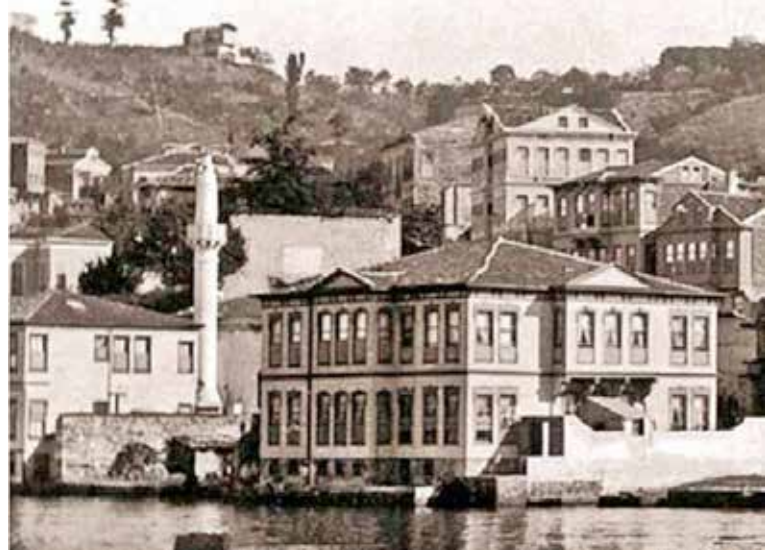
1928 yılındaki yol çalışmaları esnasında yıkılan Anadoluhisarı Fatih Camii
