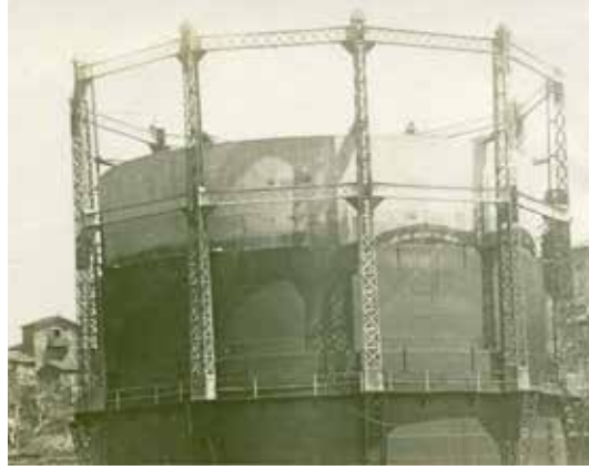
Şehrin gaz ihtiyacı Çubuklu'daki gaz depolarından karşılanıyordu. Sarayın ihtiyacı ise Dolmabahçe'deki gaz deposundan sağlanıyordu.
