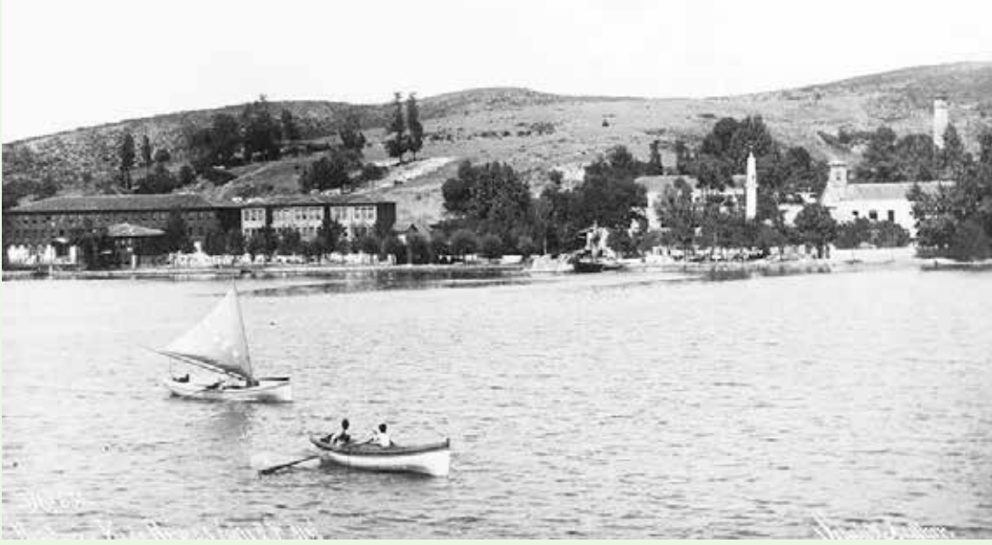
Depremde Beykoz Serbostani Mustafa Ağa Camii de hasar görmüştü.
