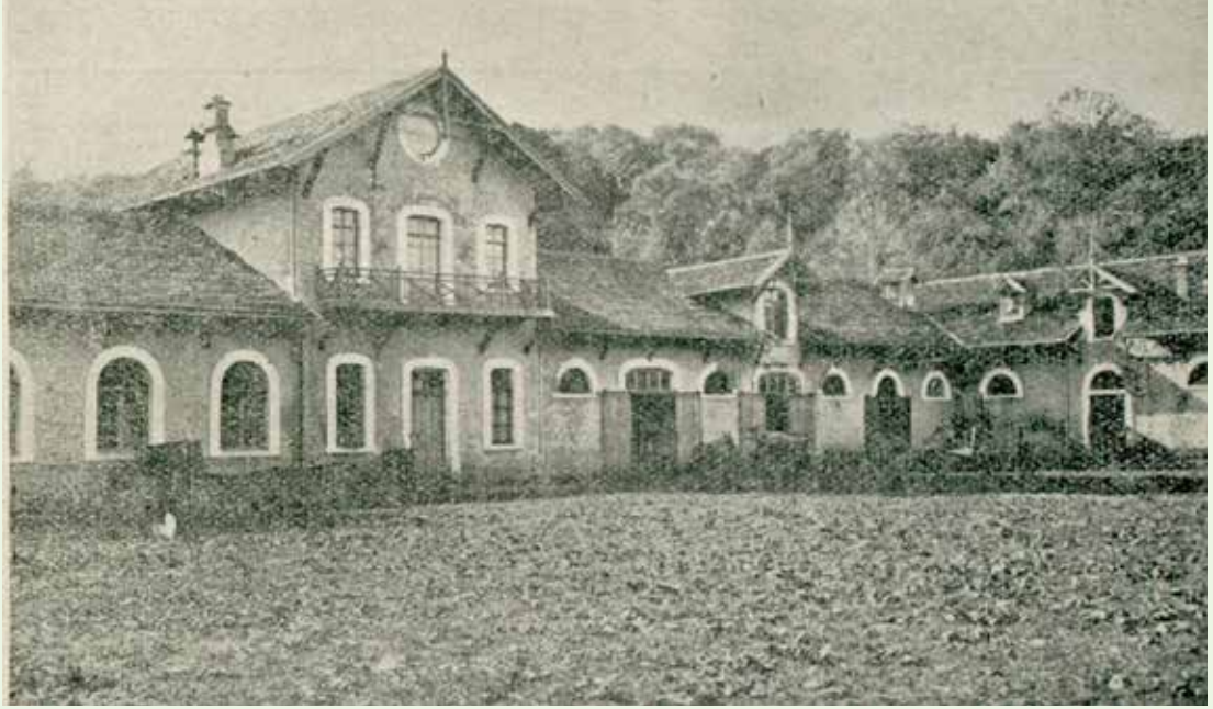
Beykoz Arpacı Çiftliği Ziraat Mektebi binası
